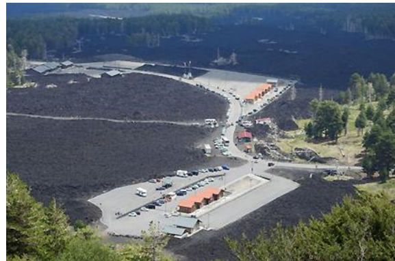
Jede Zerstörung bietet auch die Chance für eine Modernisierung – neu erbaute Infrastruktur an der Piano Provenzana zehn Jahre nach der Eruption
