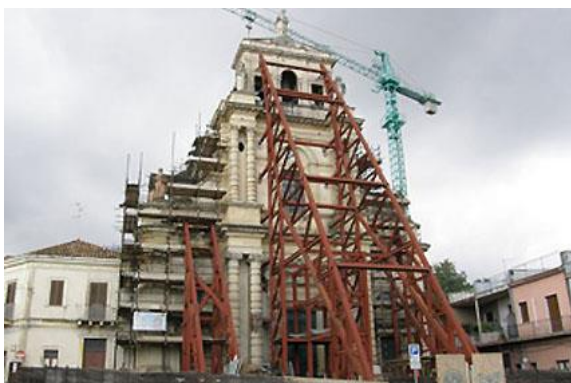
Beseitigung von Erdbebenschäden an der Chiesa Parrocchiale del Sacro Cuore (Church of the Sacred Heart) in Santa Venerina, entstanden durch das Beben vom 29.10.2002
